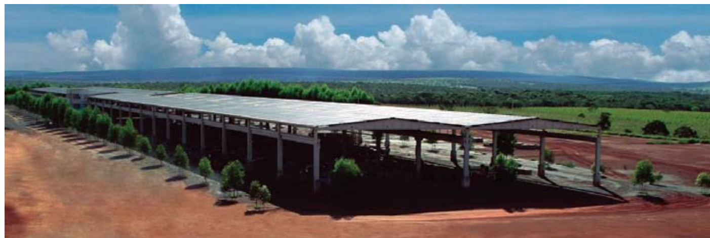
Localizada em Martinho Campos (MG), a indústria de beneficiamento da Altivo Pedras é uma referência no Brasil Located in Martinho Campos (MG), Altivo Pedras beneficiation plant is a reference in Brazil
